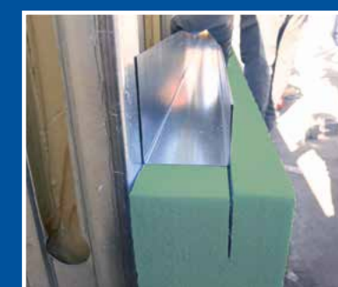
Posa dei pannelli isolanti da cappotto
