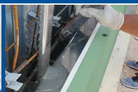
Getto del betoncino strutturale Ferrimix di opportuna resistenza meccanica in funzione della scelta progettuale
